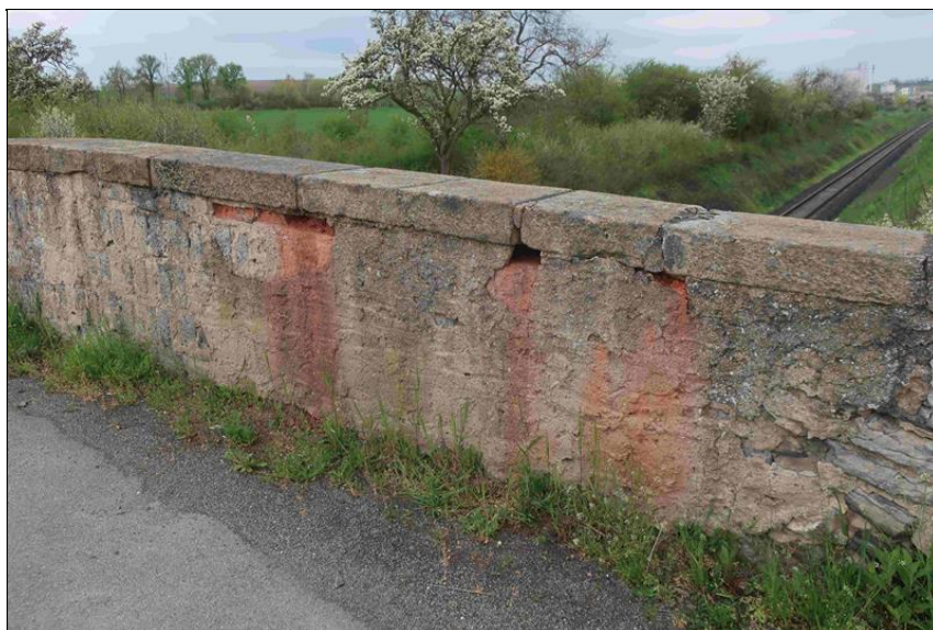
levá parapetní zeď - poruchy spárování pod kvádry koruny
