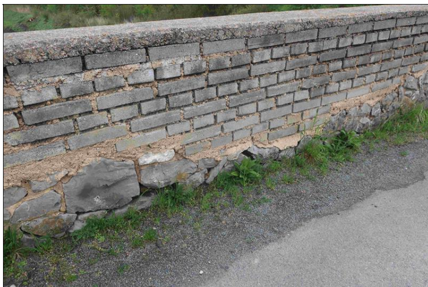
pravá parapetní zeď - poruchy spárování, uvolněné kameny v úrovni vozovky
