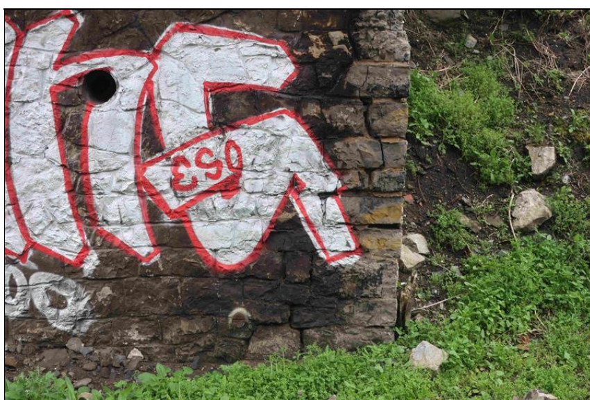
O1 - svislá trhlina ve zdivu podél levé hrany dřívku opěry
