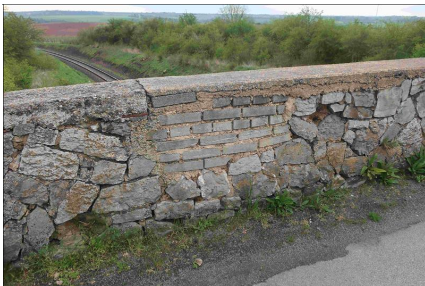
pravá parapetní zeď - poruchy spárování, uvolněné kameny
