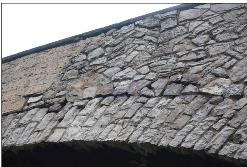
levá poprsní zeď - poruchy spárování
