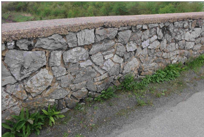
pravá parapetní zeď - poruchy spárování, uvolněné kameny
