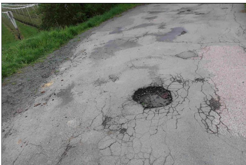
výtluky v krytu vozovky na předmostí před O1
