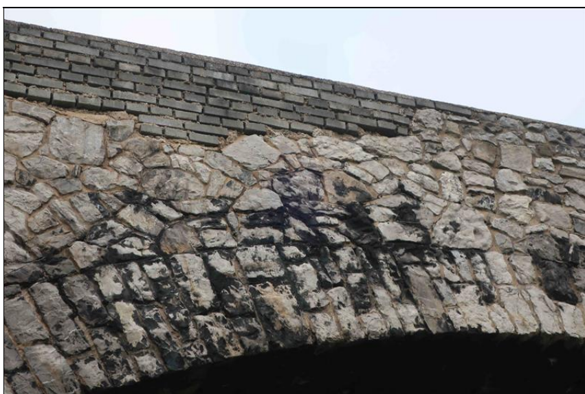
pravá poprsní zeď - poruchy spárování
