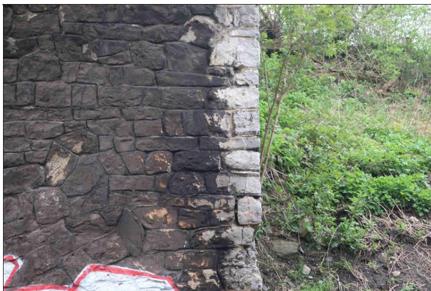
DTTO - dílčí oprava zdiva pod klenbovým pasem
