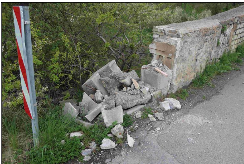
levá parapetní zeď - rozpad čela zdi
