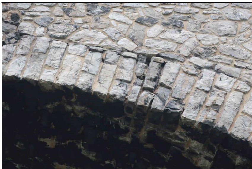
pravý bok klenbového pasu - poruchy spárování
