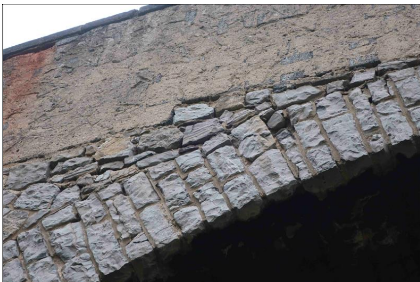
poruchy spárování zdiva na levém boku klenbového pasu
